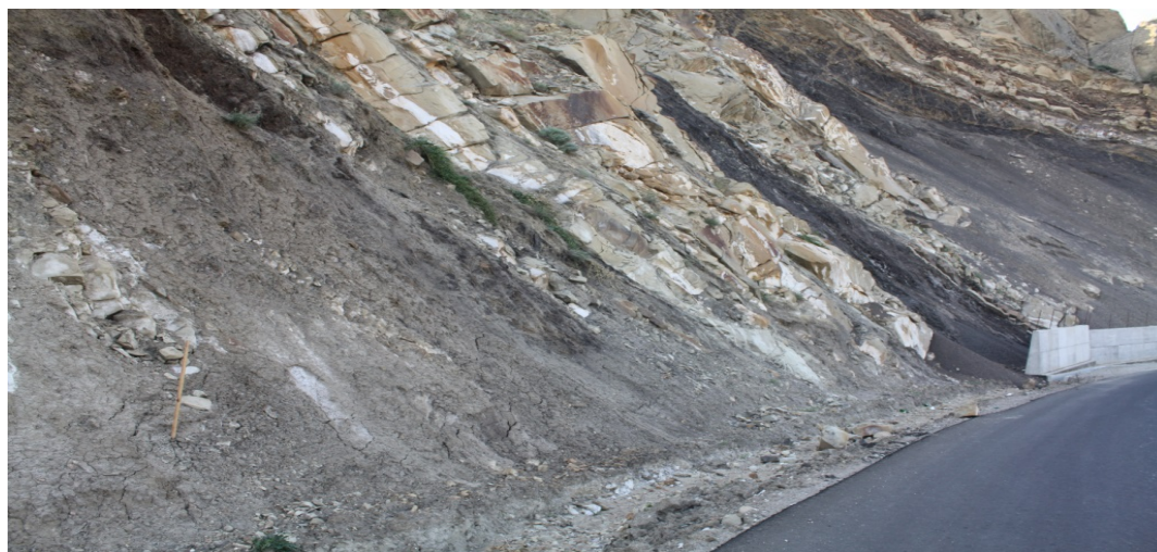
Рисунок 6.17 – Выемочный глинисто-сланцевый и скально-песчаниковый откос (восточный микросклон северного макросклона Нарат-тюбинского хребта). ПП № 7
