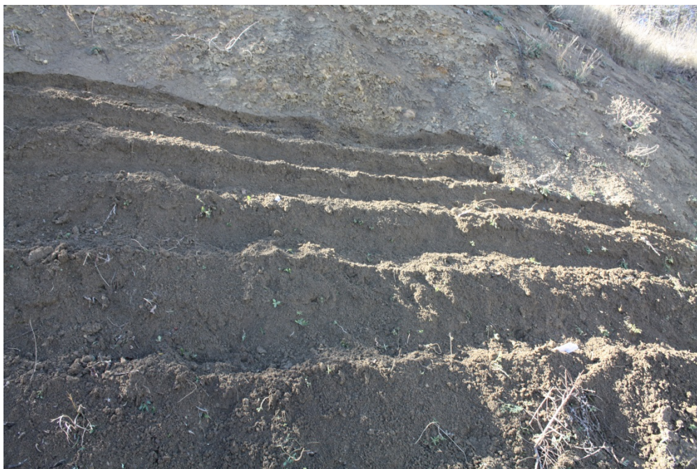
Рисунок 6.19 – Подготовка грунта под посев семян древесных видов для оценки биоинженерного метода закрепления откосов автодорог. Ноябрь 2019 г. Северный склон Нарат-тюбинского хребта
