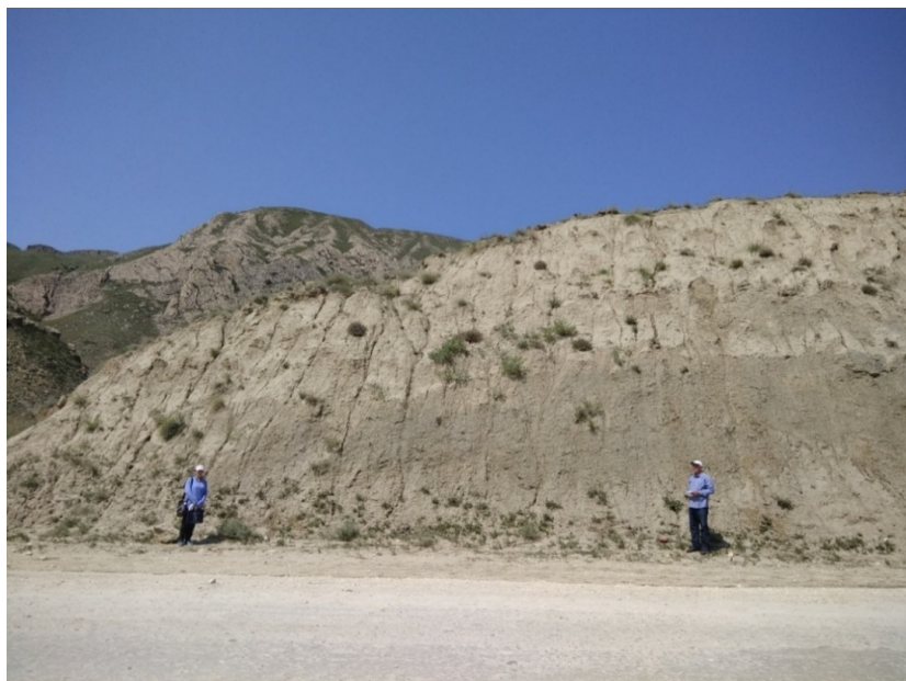
Рисунок 6.28 – Обрастание откоса южной экспозиции на левашинском спуске в сторону Хаджалмахи на глинистом грунте (ПП № 5. 1206 м над ур. м.)
