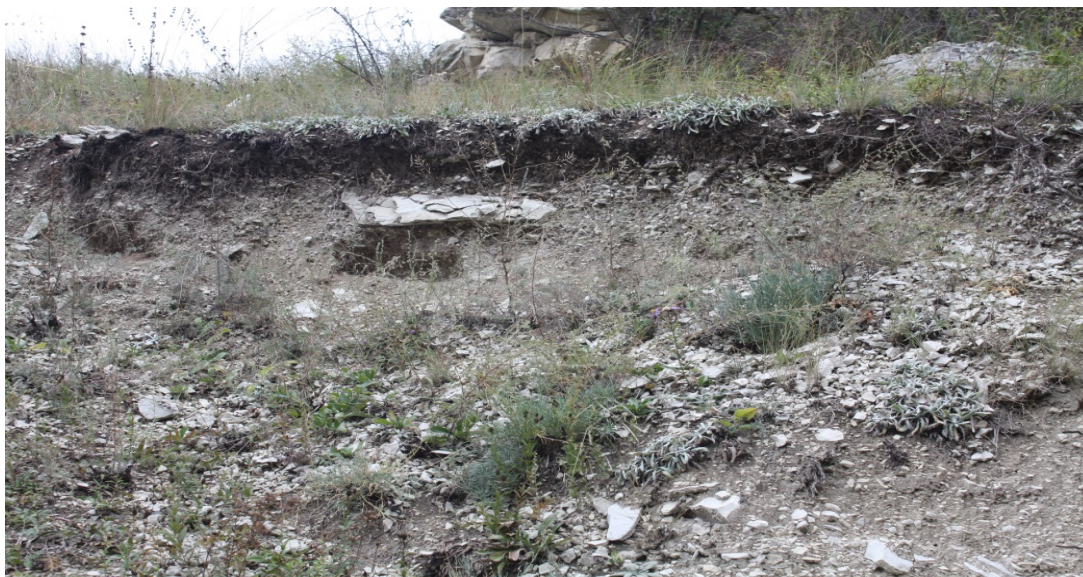
Рисунок 6.32 – Типичная картина зарастания выемочных откосов автодорог на южных склонах Внутреннегорного Дагестана. Видно полное зарастание бермы шалфеем седоватым. Этот вид является индикатором нарушенности склонов, занимает оголенные участки и края микрообрывов. На площадках террас этот вид не встречается.
