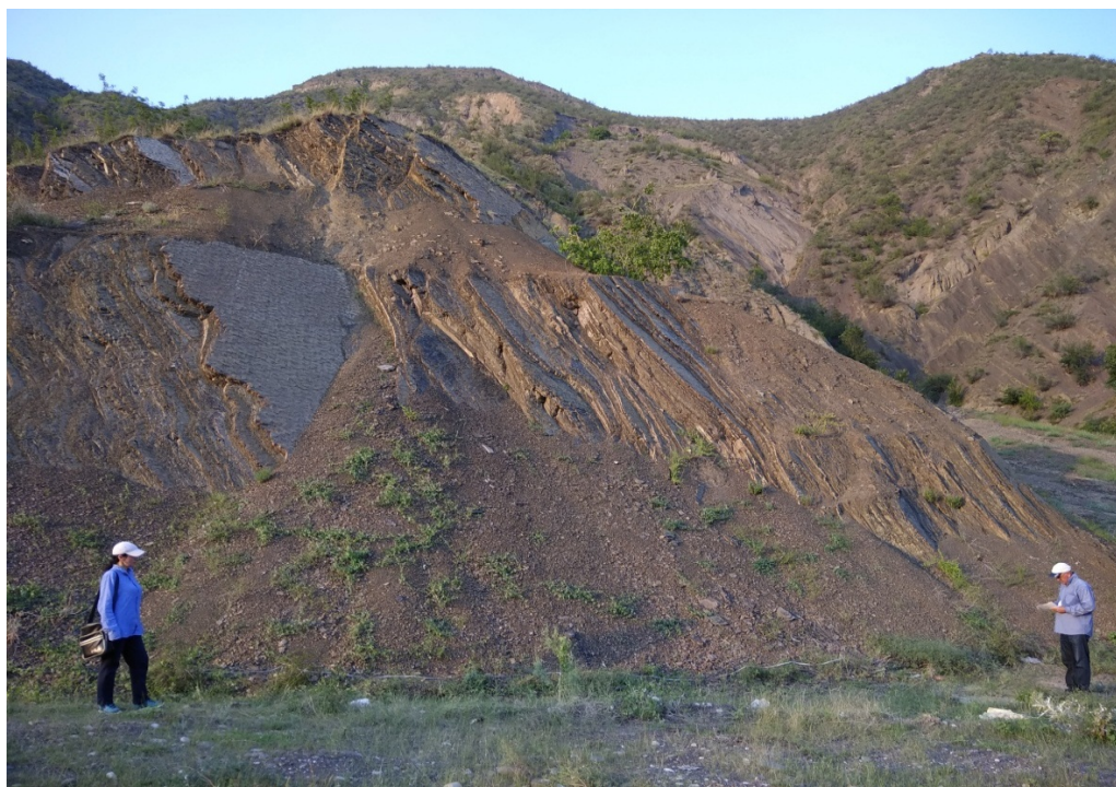
Рисунок 6.31 – Обрастание выемочного откоса Внутреннегорного Дагестана из сланцевого грунта (ПП № 9 автотрассы Кикунь – Майданское).
